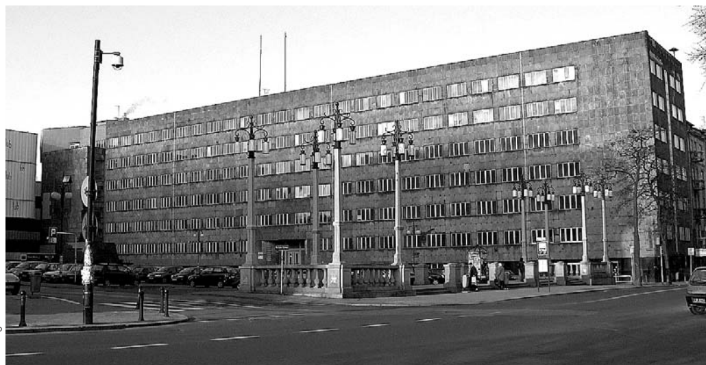
Foto: Agnieszka Sikora Budynek Wydziału Filologicznego w Katowicach, pl. Sejmu Śl. 1
