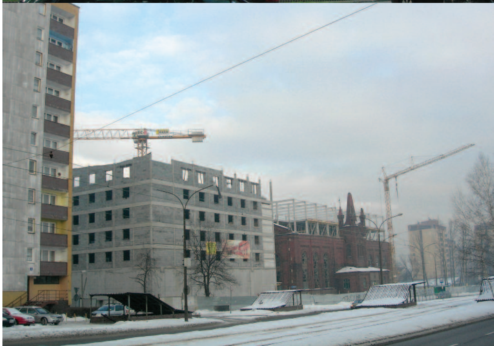
Sosnowiec, dzielnica Sielec. Budowa hotelu uwzględniająca rewitalizowany obiekt dawnej elektrowni kopalnianej
