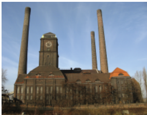
Elektrociepłownia Szombierki, Bytom
